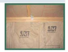
2 Cut Insulation To Fit Around Obstructions / Corte el aislante de manera que se acomode alrededor de las obstrucciones
