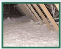
Insulation Must Touch The Sheetrock / El aislante debe tocar la tabla yeso
