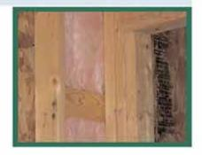
Ensure Floor Insulation Touches The Floor With Minimal Compression / Asegúrese que el aislante toque el piso con compresión mínima
