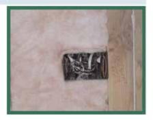
Attic Insulation Must Touch Sheetrock / El aislante para el ático tiene que hacer contacto con la tabla yeso
