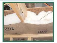
Split Insulation Around Wiring / Corte el aislante y acomódelo alrededor de los cables eléctricos
