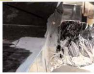
Seal All Seams In Plenum With Mastic / Selle todas las uniones en el plenum con masilla
