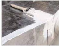
Use Mastic And Fiberglass Mesh Tape To Connect Plenum To Air Handler / Use masilla y cinta de fibra de vidrio para unir el plenum a la manejadora de aire
