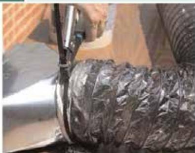
**4** Apply Mastic To Connection / Aplique masilla en la conexión
