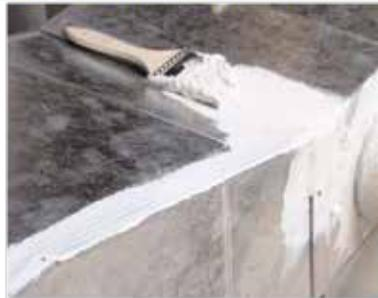
**7** Use Mastic And Fiberglass Mesh Tape To Connect Plenum To Air Handler / Use masilla y cinta de fibra de vidrio para unir el plenum a la manejadora de aire
