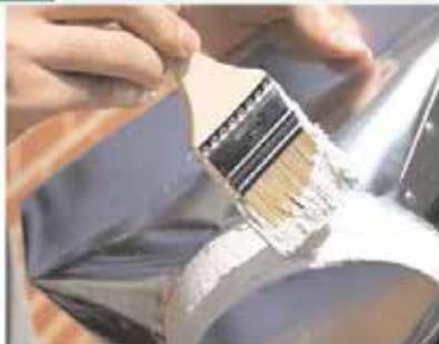
**2** Pull Liner Onto Boot / Meta el cuello del adaptador en el ducto
