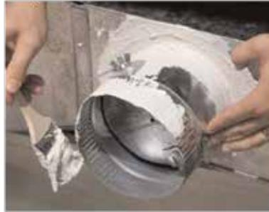
**3** Attach Flex Duct And Zip Tie / Asegure el ducto flexible con un amarre plástico
