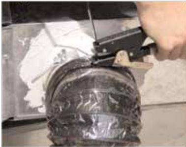
**4** Apply Mastic To Connection / Aplique masilla a la conexión
