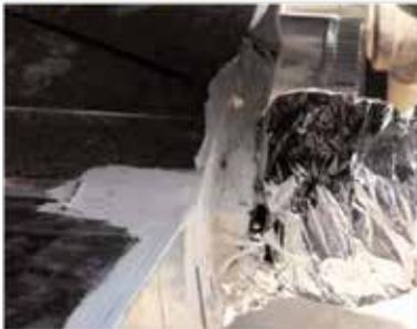
**6** Seal All Seams In Plenum With Mastic / Selle todas las uniones en el plenum con masilla
