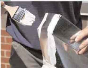
**8** Seal Boot To Subfloor / Selle las uniones entre el adaptador y el piso falso
